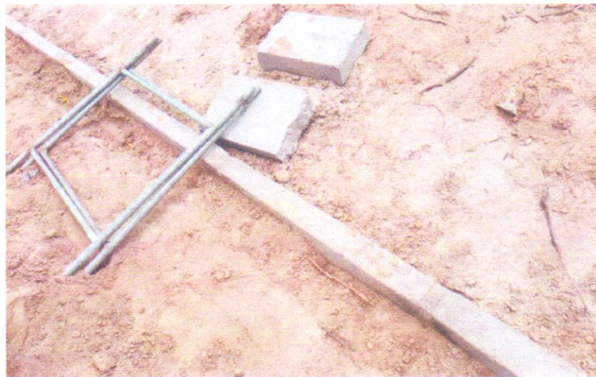
FOTO 05 – ASSENTAMENTO DE GUIA (MEIO-FIO) EM TRECHO RETO, CONFECCIONADA EM CONCRETO PRÉ-FABRICADO, DIMENSÕES 80X08X08X25 CM (COMPRIMENTO X BASE INFERIOR X BASE SUPERIOR X ALTURA), PARA URBANIZAÇÃO INTERNA DE EMPREENDIMENTOS. AF_06/2016
