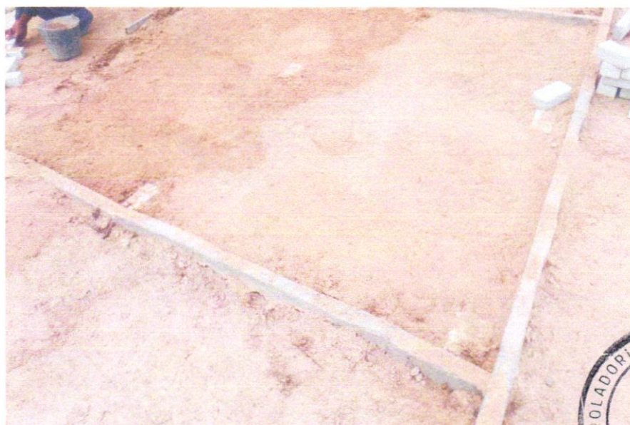
FOTO 04 - REATERRO MANUAL COM COMPACTAÇÃO MECANIZADA EM CAMADAS DE 0,20 M NO MÁXIMO, COM MATERIAL DA PRÓPRIA OBRA
