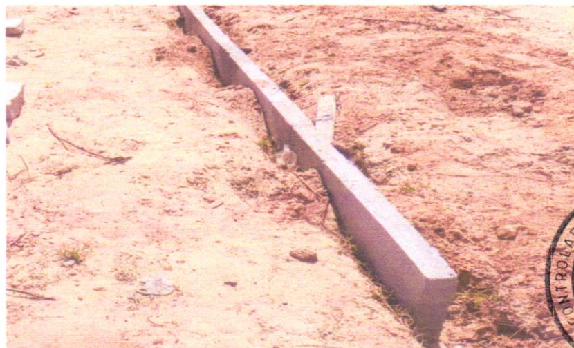
FOTO 06 – ASSENTAMENTO DE GUIA (MEIO-FIO) EM TRECHO RETO, CONFECCIONADA EM CONCRETO PRÉ-FABRICADO, DIMENSÕES 80X08X08X25 CM (COMPRIMENTO X BASE INFERIOR X BASE SUPERIOR X ALTURA), PARA URBANIZAÇÃO INTERNA DE EMPREENDIMENTOS. AF_06/2016
