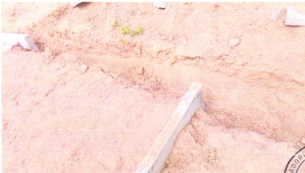
FOTO 02 – ESCAVAÇÃO MANUAL DE VALA COM PROFUNDIDADE MENOR OU IGUAL A 1,30 M
